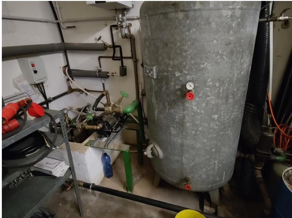
**Foto 17:** Wassertank im Gebäude der Fa. Strittmatter zur Zwischenspeicherung des Trinkwassers
