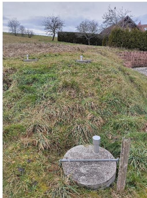
**Foto 14:** Blick auf die untere Quellfassung. Im Hintergrund sind die höher gelegenen Schachtdeckel des Filterschacht und Sammelbehälters zu sehen.
