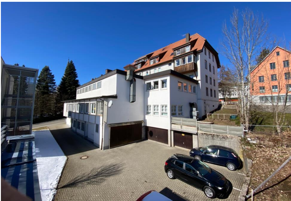
Blick auf die Rückseite des Hauses Gerwigstraße 35/37 von der Stadtterrasse (Edeka) aus. In den drei Etagen - hier im Bild neben den Garagen (UG 2) und darüber (UG1 und EG) - könnte eine neue Kindertageseinrichtung entstehen.
