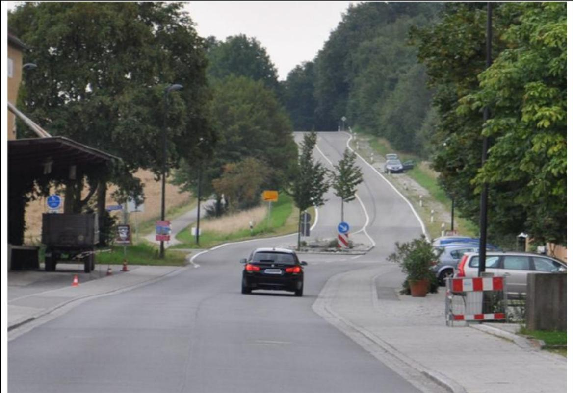
Abbildung 26: Beispiel für eine Verkehrsinsel und Fahrbahnverschwenkung
