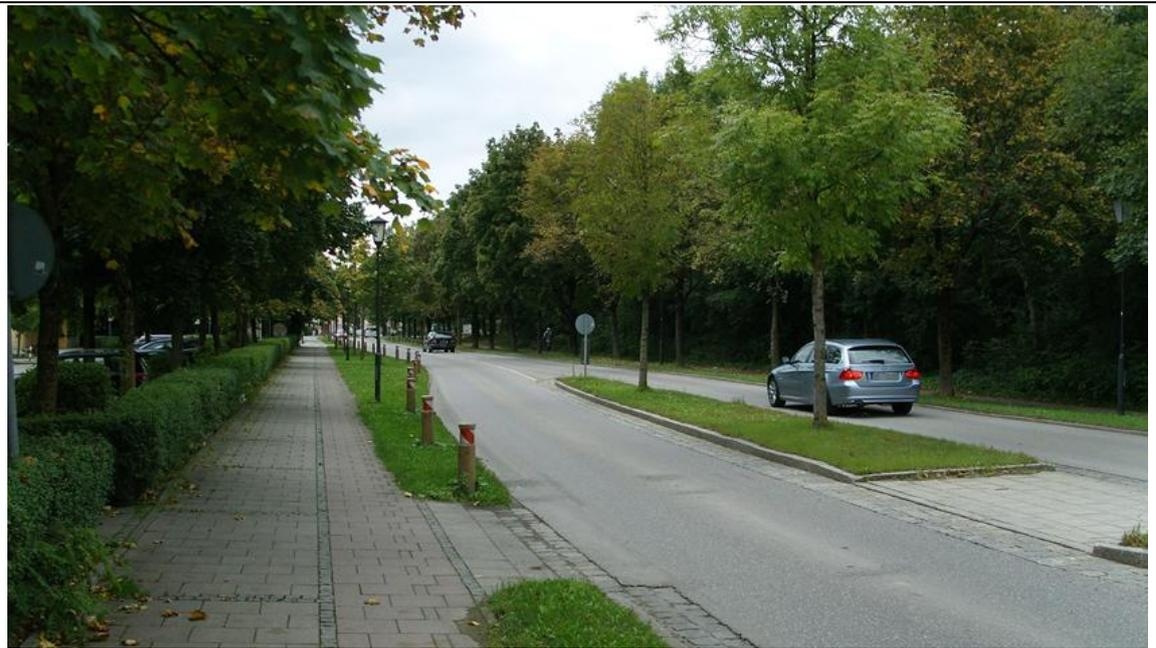
Abbildung 27: Beispiel einer Verengung einer Fahrbahn
