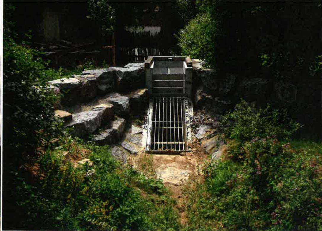
*Innerörtliche Überflutungen lassen sich durch optimierte Einlaufbauwerke eindämmen (Beispiel: Einlaufbauwerk Neuenstadt)*
