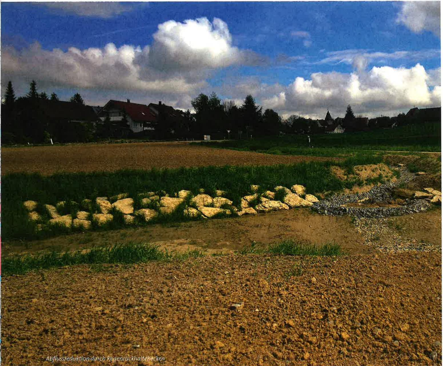
*Abflussreduktion durch Regenrückhaltebecken*
